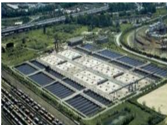
Поглед на огромно техничко постројење за пречишћавање отпадних вода у Хамбургу Извор: http://www.vdi.de/2151.0.html
