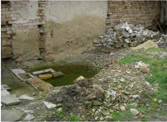
Апсорпциона јама напуњена отпадним водама
