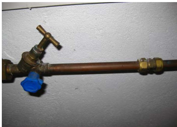
Бакарне цеви одликују трајност и поузданост, али су релативно скупе.
