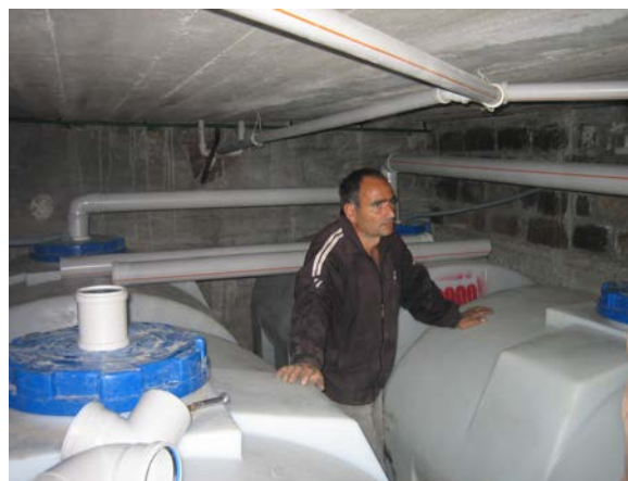
Школски СТПУ: подрум са резервоарима за сакупљање, складиштење и третман урина за 350 корисника
