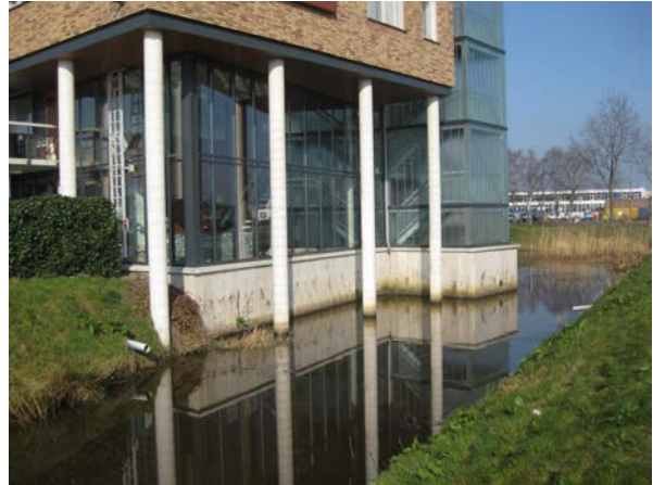
Вештачки водени ток/ров за задржавање кишнице
