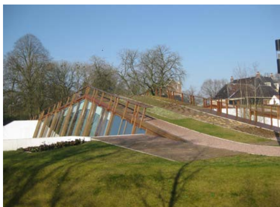
Пример екстензивног зеленог крова јавне зграде
