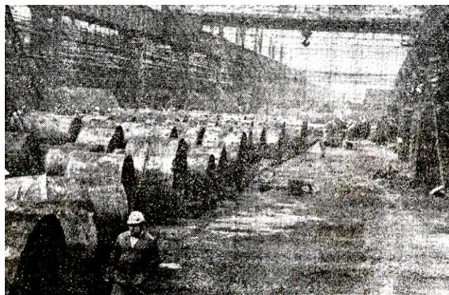
Slika 3. Unutrašnjost izgorele hladne valjaonice
