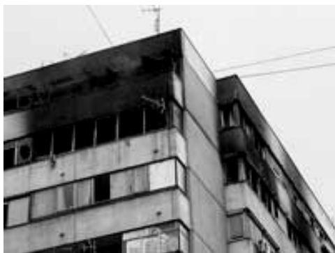
Slika 2. Požar na VIII spratu stambene zgrade preneo se po vertikali na IX i X sprat. U ovom požaru su dve osobe izgubile život i uništena su tri stana.
