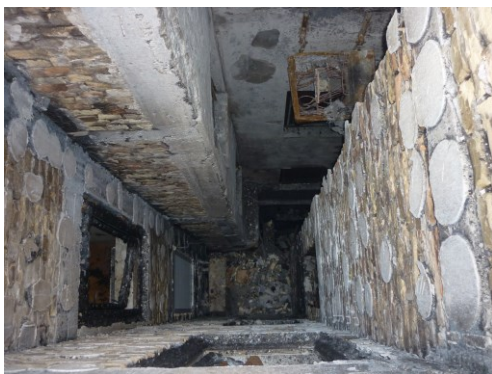
Slika 3. Prenos požara po fasadi svetlarnika: Obloga od stiropora sa završnim slojem maltera je potpuno uništena u požaru, vatra se širila i prema gore i prema dole od prozora stana na trećem spratu, kroz termoizolacioni sloj, do potkrovlja
