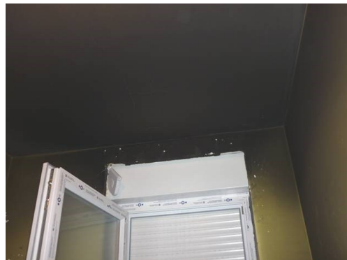
Slika 4. Oštećenja i tragovi požara na unutrašnjoj oblozi od gipsa u stanu u potkrovlju: vatra se širila kroz termoizolacioni sloj u krovu
