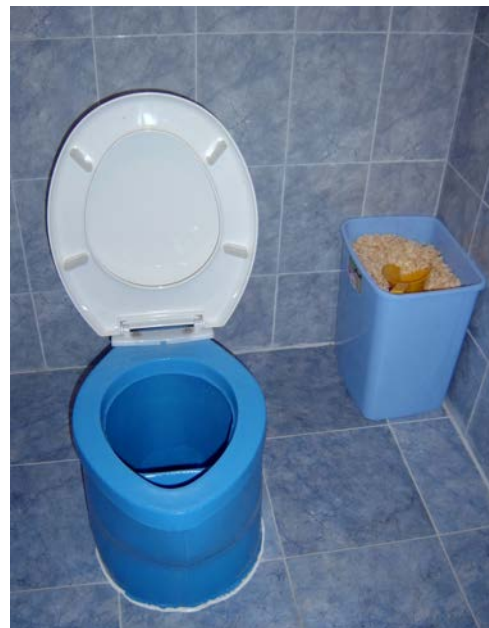
Унутрашњост кабине Екосан тоалета (СТПУ), изграђене у кући у Бугарској. Фотографија: Earth Forever
