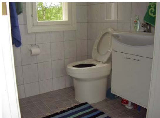
Компостни тоалет у Финској Фотографија: Кати Хикканен (Kati Hinkkanen)
