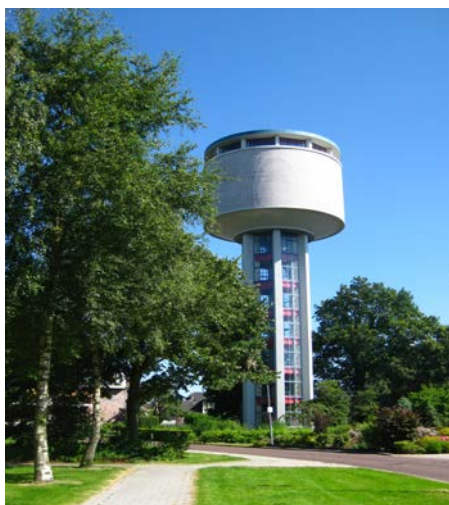
Водоторањ који одржава одговарајући притисак дању и ноћу
