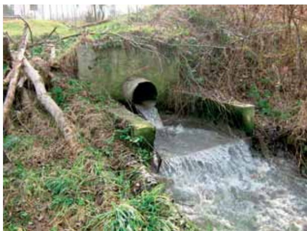
Deo postrojenja za prečišćavanje otpadnih voda Facility for waste water treatment [Autor/Author: Milica Petrović]
